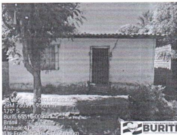
Figura 1: Foto do Terreno
