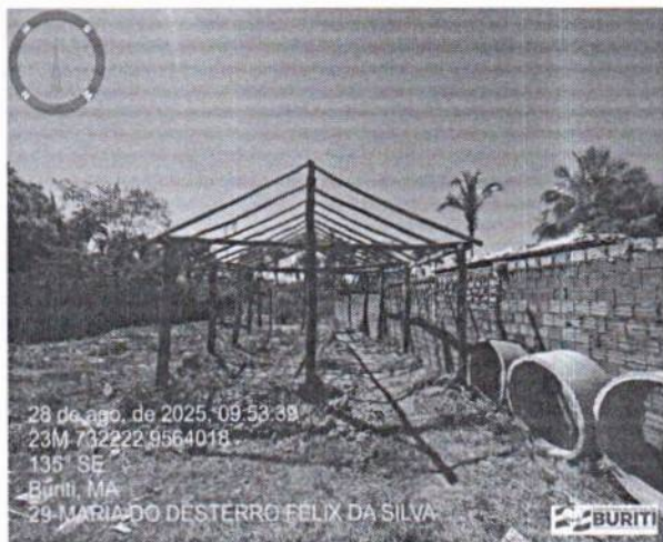
Figura 1: Foto do Terreno
