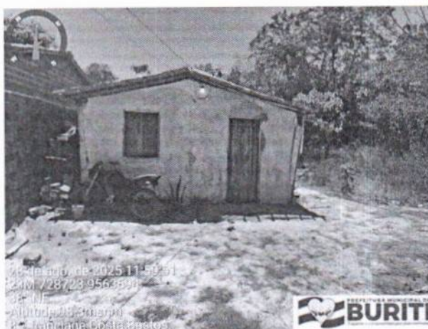
Figura 1: Foto do Terreno
