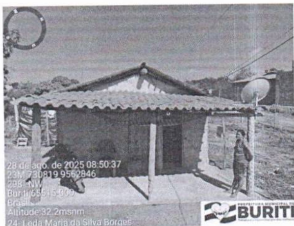
Figura 1: Foto do Terreno
