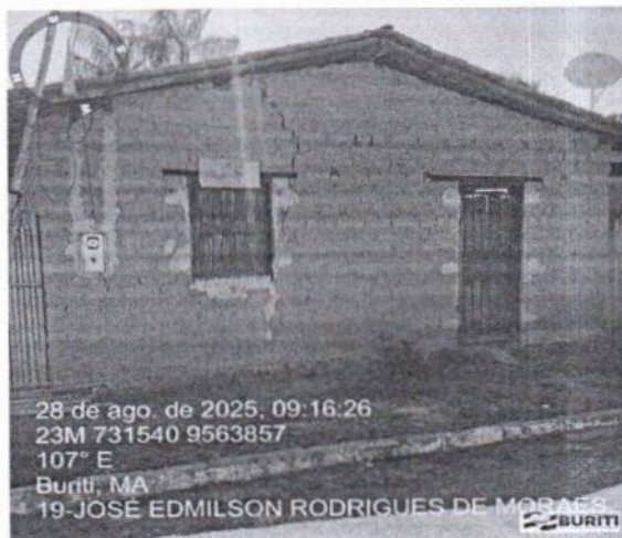
Figura 1: Foto do Terreno
