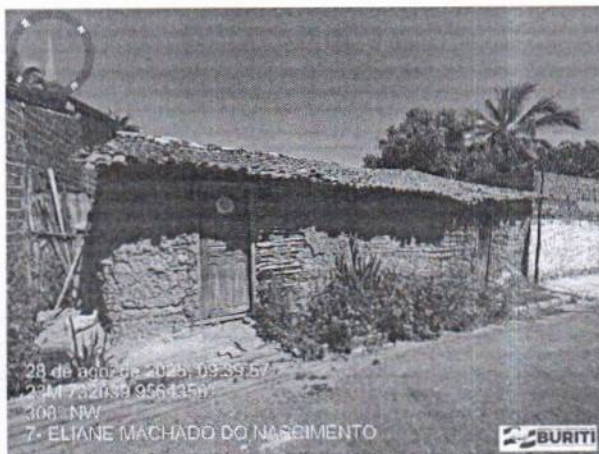
Figura 1: Foto do Terreno
