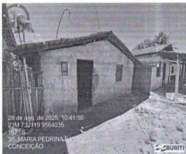
Figura 1: Foto do Terreno
