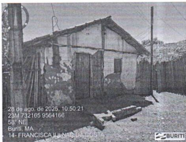
Figura 1: Foto do Terreno
