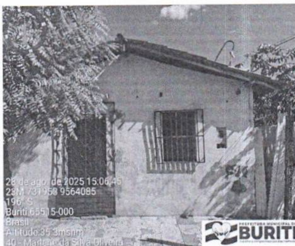
Figura 1: Foto do Terreno
