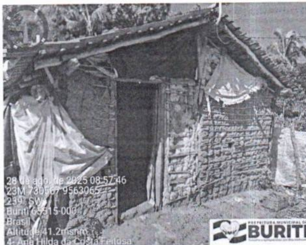
Figura 1: Foto do Terreno
