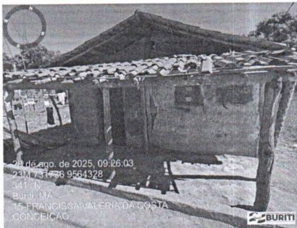
Figura 1: Foto do Terreno
