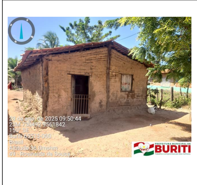
Figura 1: Foto do Terreno
