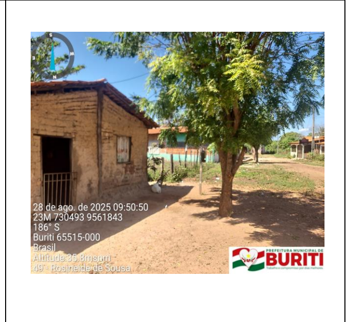
Figura 2: Foto da Via de Acesso
