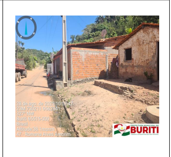
Figura 2: Foto da Via de Acesso
