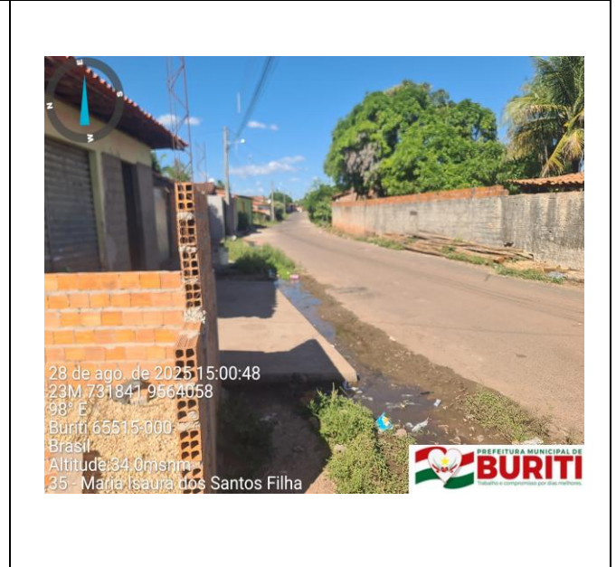
Figura 2: Foto da Via de Acesso
