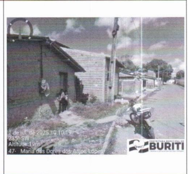
Figura 2: Foto da Via de Acesso
