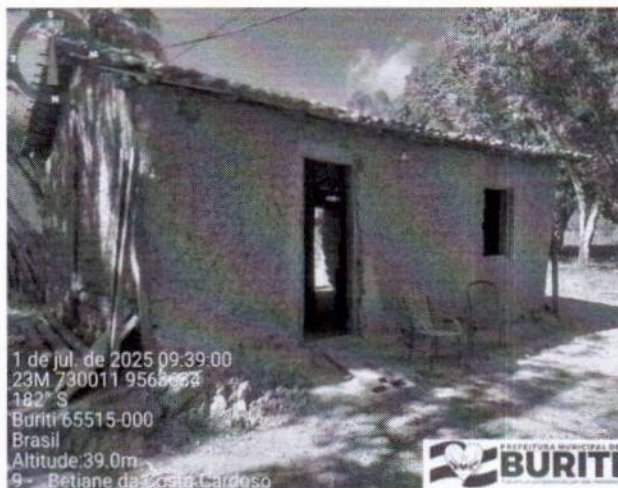
Figura 1: Foto do Terreno
