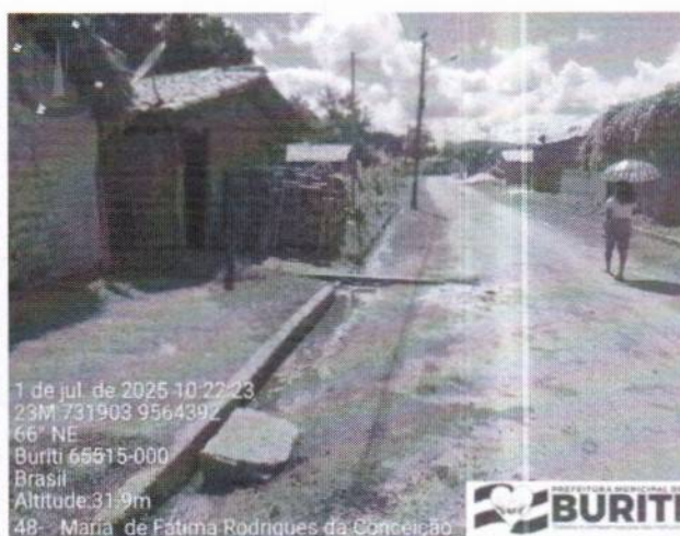
Figura 2: Foto da Via de Acesso
