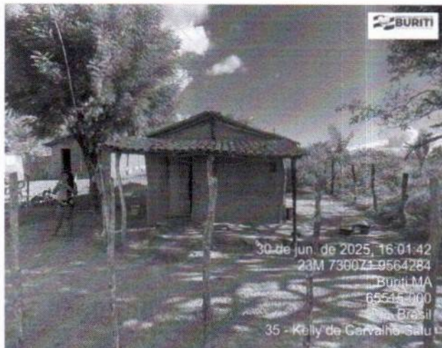
Figura 1: Foto do Terreno
