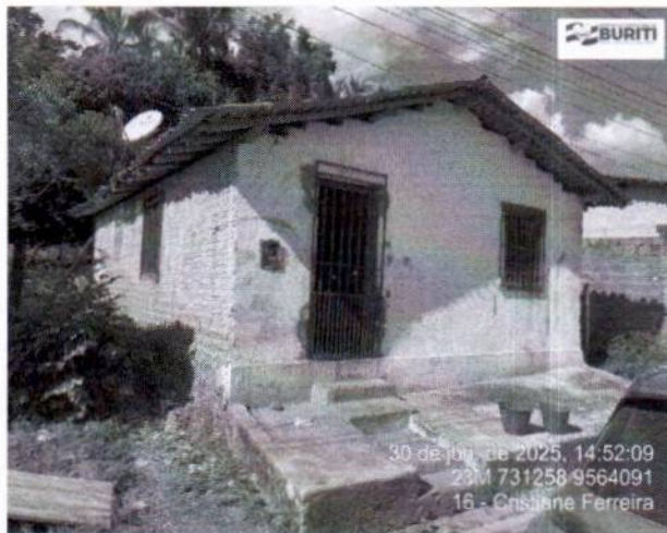
Figura 1: Foto do Terreno
