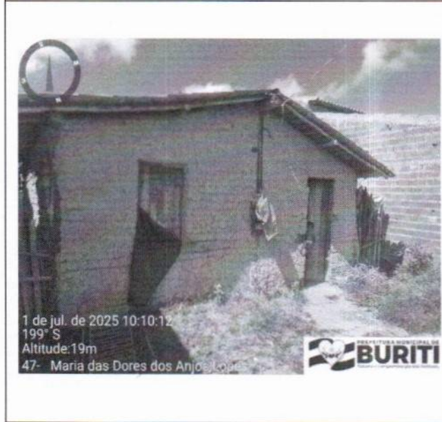
Figura 1: Foto do Terreno
